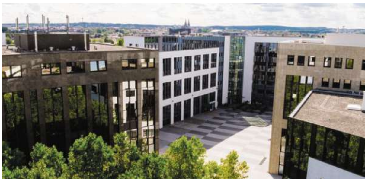
Immobilienleister mit Weitblick: Im Gewerbepark Regensburg wurden bereits vor 20 Jahren Glasfaserringleitungen gelegt. Timo Lauber
